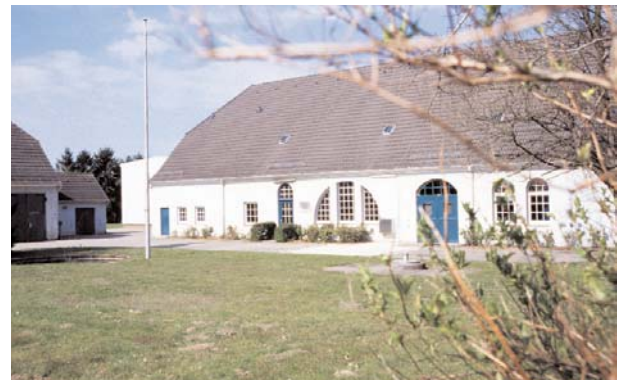
Blick auf das Maschinenhaus
